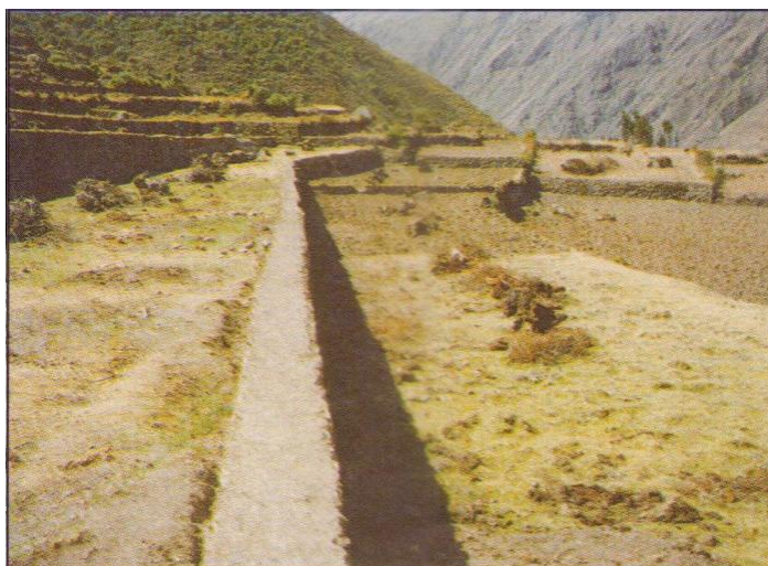
Foto 4. Consolidación y restauración de los andenes de Choquebamba.
