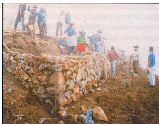
Foto 2. Reconstrucción del muro.
