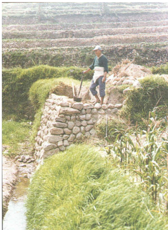
Foto 5. Reconstrucción de un muro que falló en condición cohesiva, por la base, durante una lluvia.
