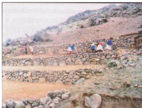
Foto 3. Nivelación del terraplén del andén.
