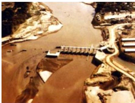
Colapso del vertedero fijo (FEN 1983).
