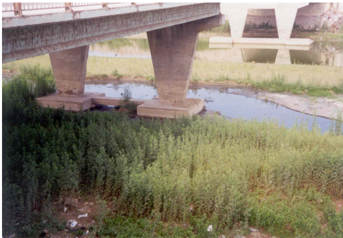
Pilares Puente Bolognesi- Piura
